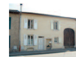
14 encadrement porte de grange
