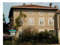
25 facade sur rue et sur cour
