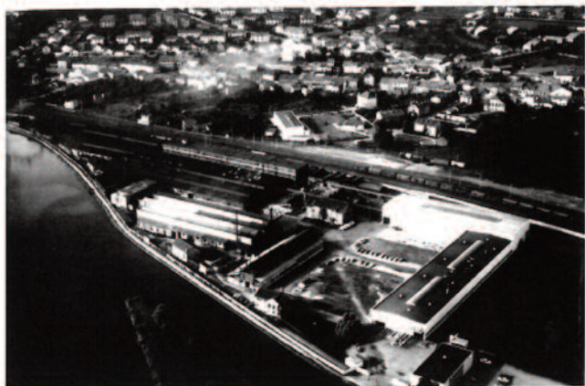
Vue aérienne de l'usine Gouvry, dans les années 1970, après démolition de la SADAD.
